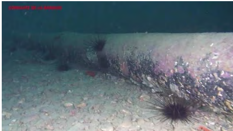
Figure 11 : Oursins diadème sur la canalisation de transfert des rejets
